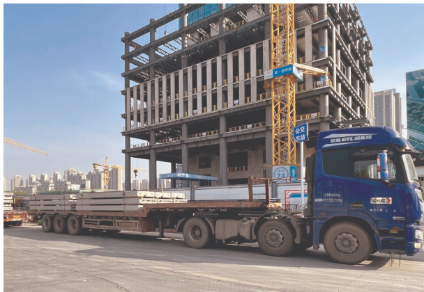
中南科研设计中心主楼装配式外墙
